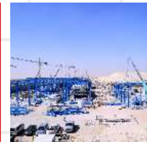
Desalinizadora de Ras Abu Fontas III, Catar
