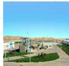
Planta de tratamiento de aguas residuales La Escalerilla, Lima, Perú
